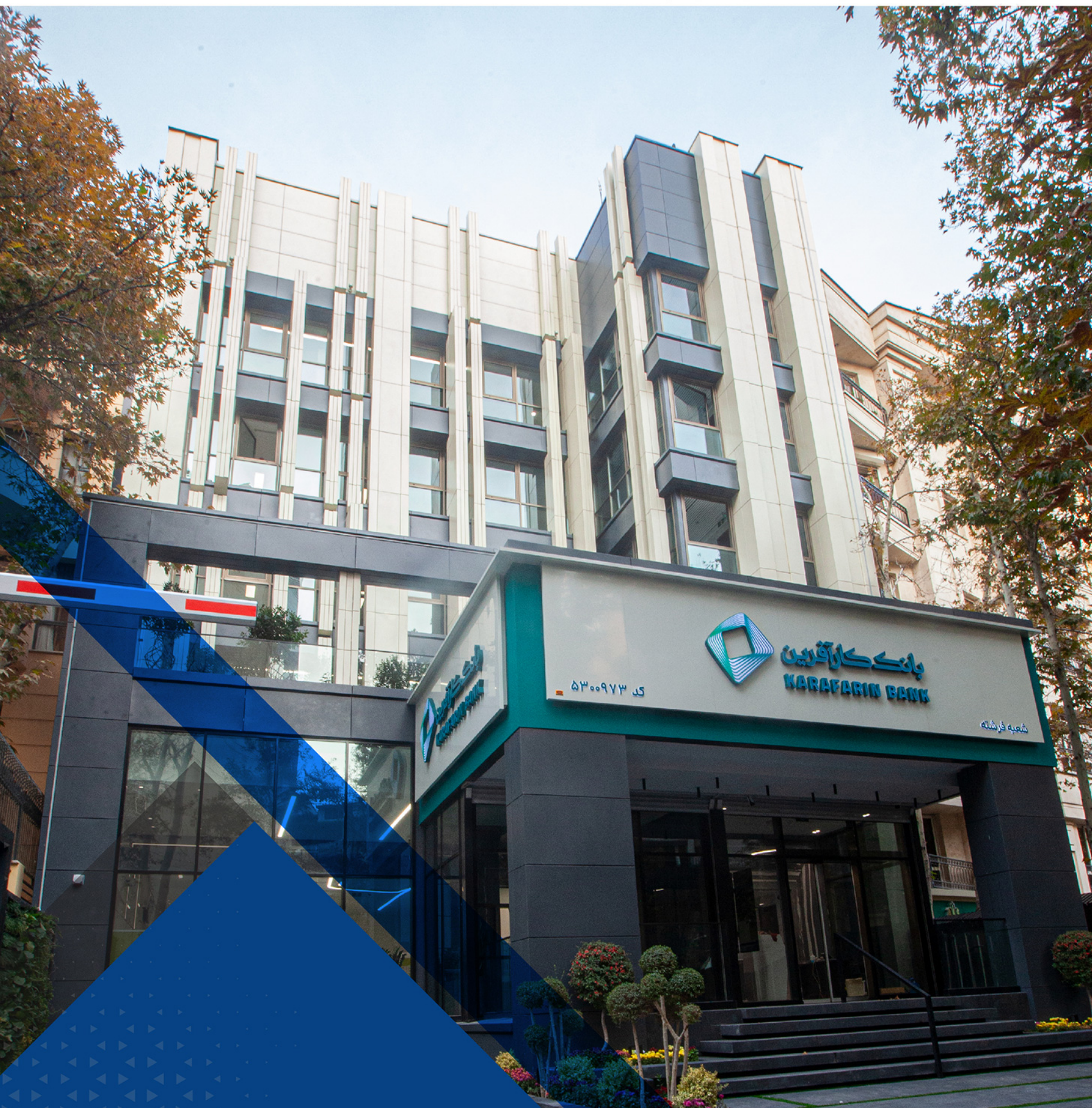
پروژه عملیات اجرایی ابنیه، تأسیسات مکانیکی و برقی پروژه بانک کارآفرین شعبه خیابان فرشته
