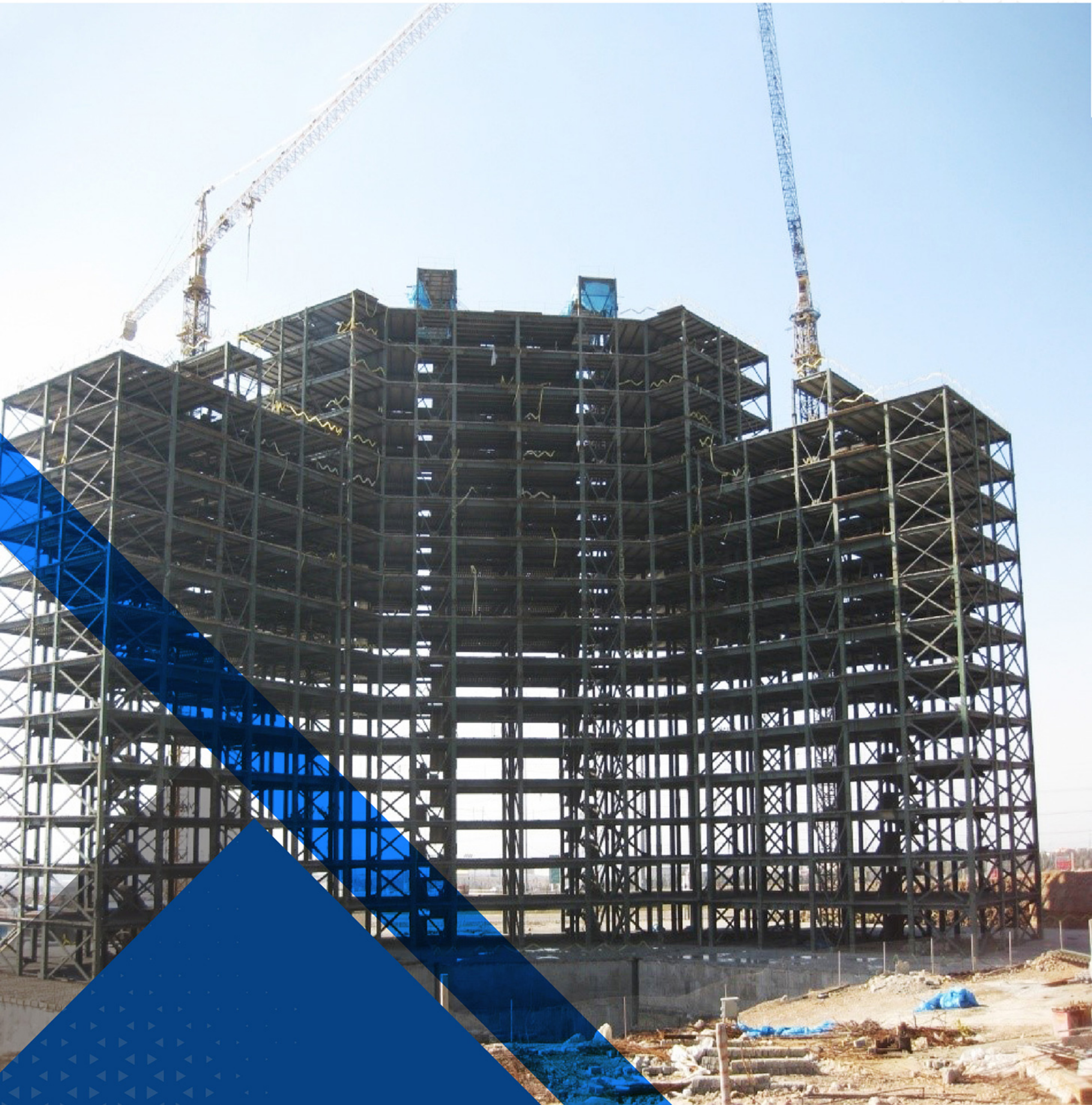
پروژه احداث مجتمع مسکونی ۶۶۰ واحدی شهرک ریحانه هشتگرد
