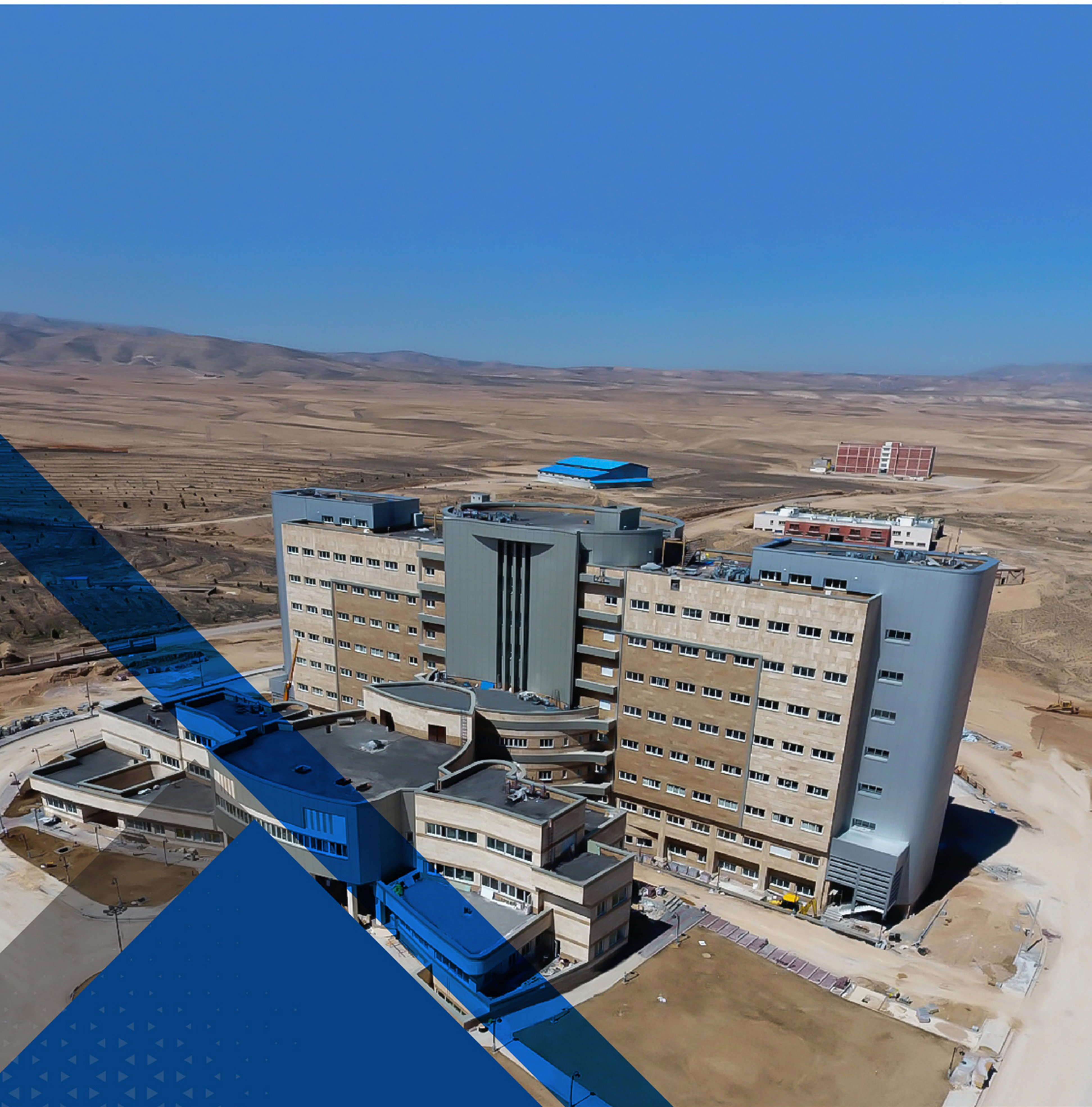
پروژه عملیات احداث ساختمان، تصفیه خانه و محوطه بیمارستان ۳۲۰ تختخوابی بجنورد
