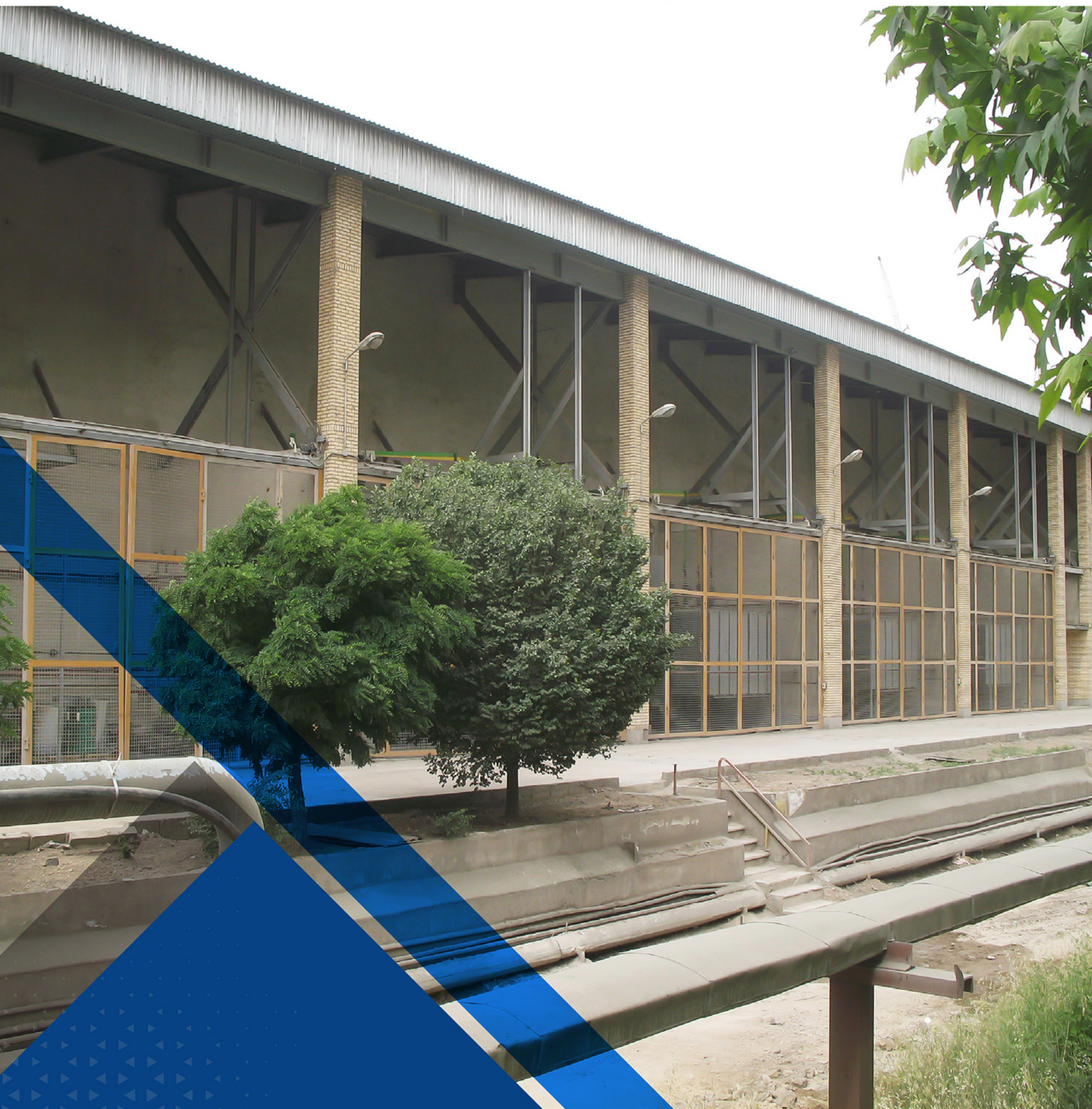
پروژه احداث پست برق فشار قوی طرح توسعه کارخانه سیمان آبیک
