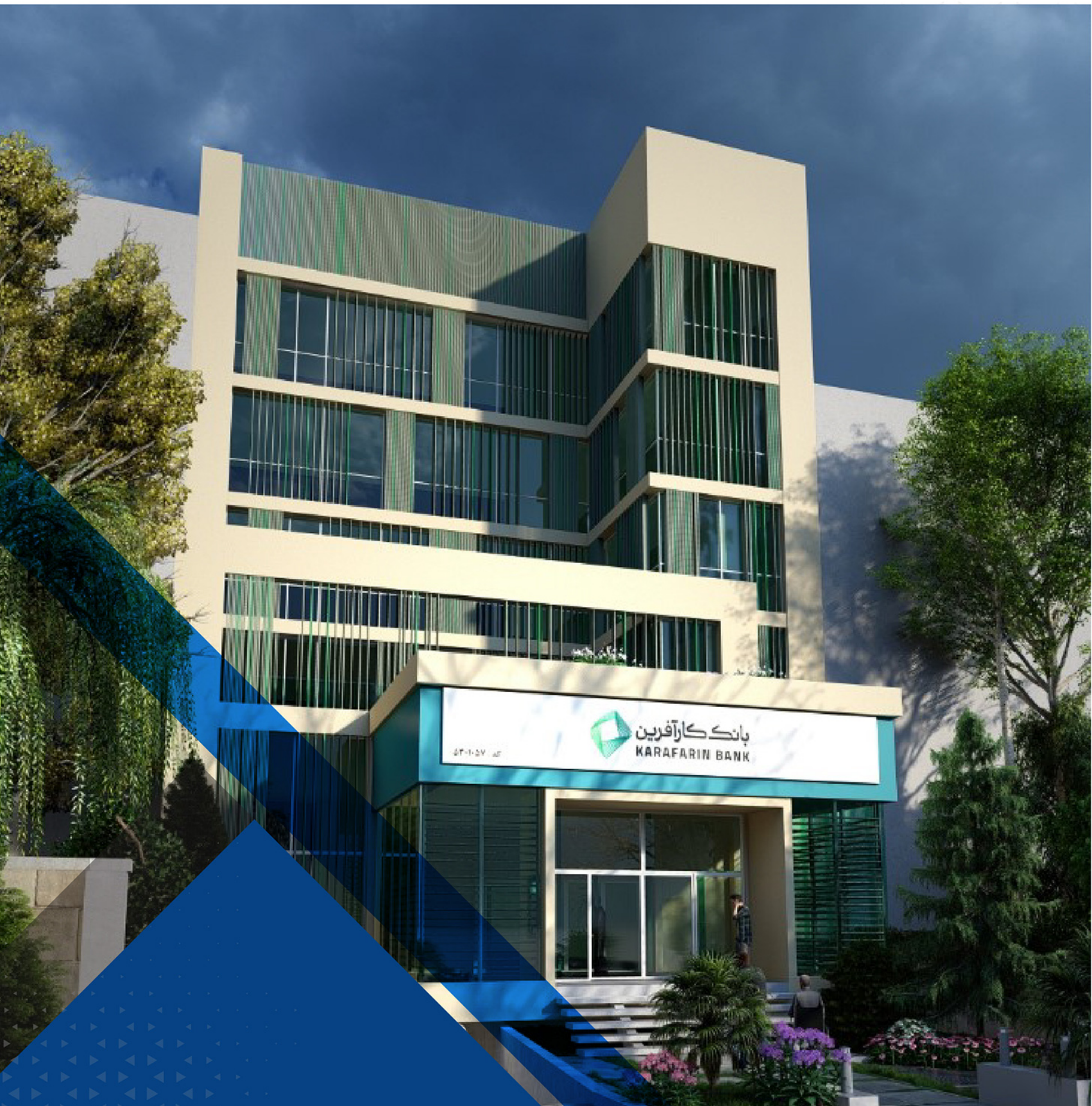
پروژه احداث سازه بانک کارآفرین شعبه خیابان فرشته
